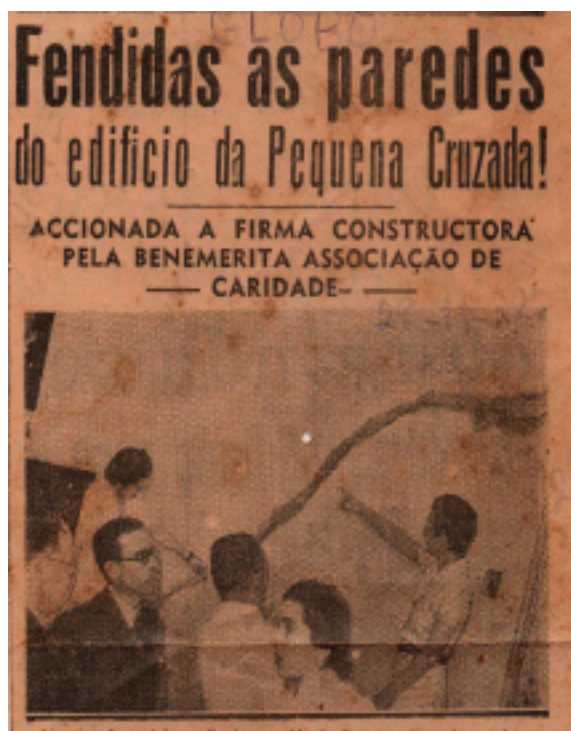
Repercussão sobre as falhas na obra da nova sede nos jornais da época.
